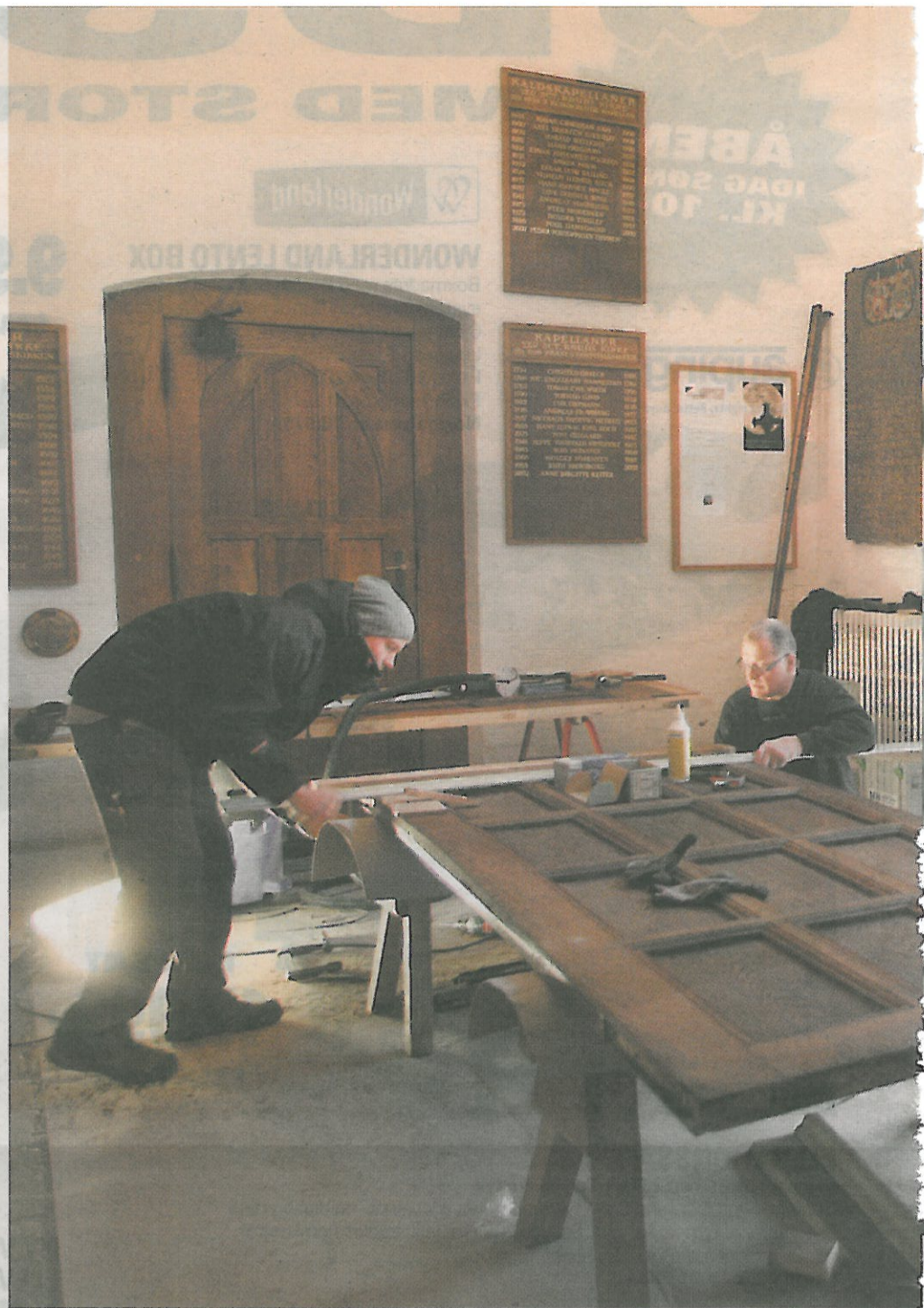
■ Herover: En af de to dørfløje på operationsbordet. Det kræver snilde og håndlag at arbejde med gamle ting. Vinkler og lige linjer er ikke præcise. Bunttykket i egetræsdøren skal skiftes og øges, så det kompenserer for det manglende trin. Bjarne Mouritsen (th) og hans lærling, Buster Nøhr Jensen.
