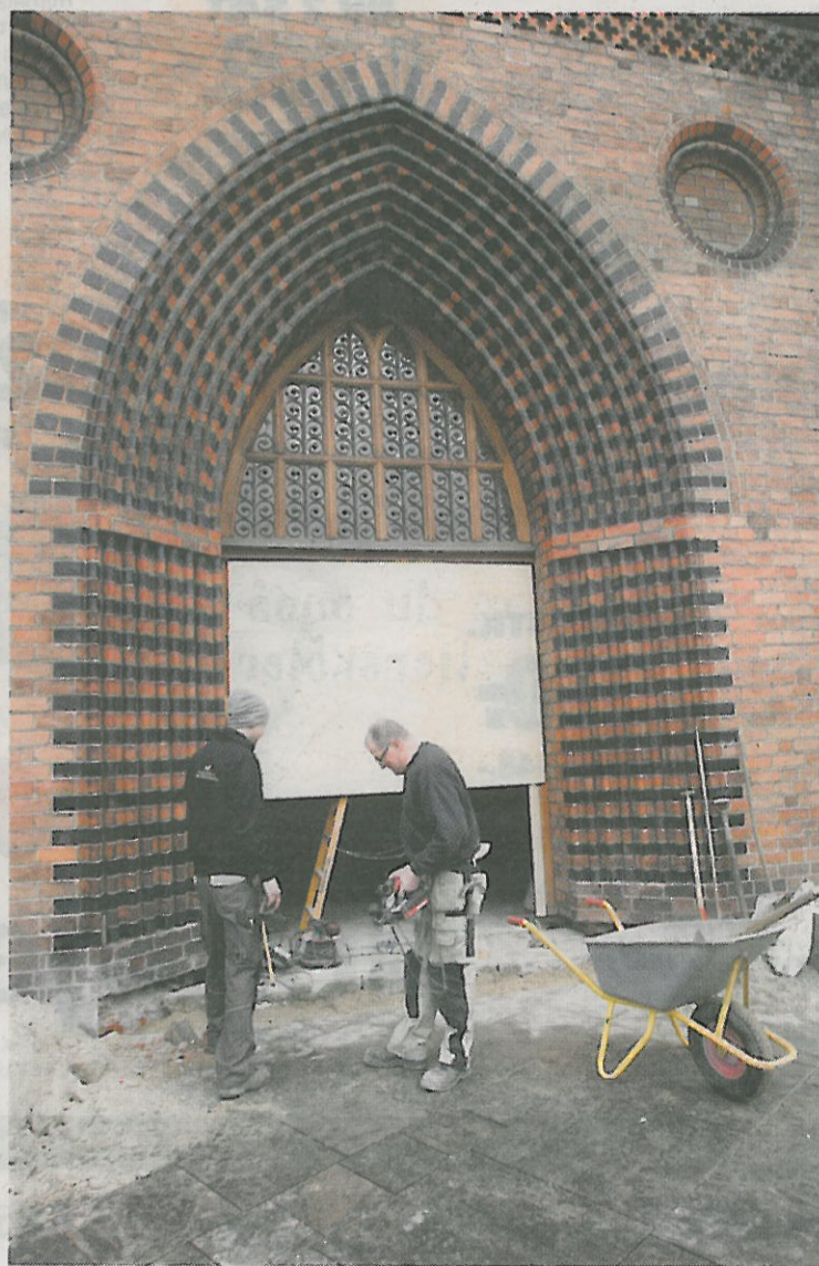
■ Herover: En af de to dørfløje på operationsbordet. Det kræver snilde og håndlag at arbejde med gamle ting. Vinkler og lige linjer er ikke præcise. Bunttykket i egetræsdøren skal skiftes og øges, så det kompenserer for det manglende trin. Bjarne Mouritsen (th) og hans lærling, Buster Nøhr Jensen.
